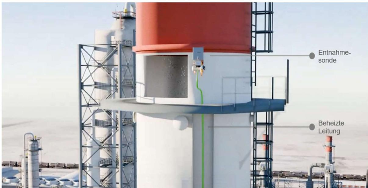
Abb. 2: Typische Verlegung einer extrudierten beheizten Emi-Leitung (auch für lange senkrechte Strecken, bis zu 300m am Stück verlegbar, Länge durch cut-to-length-Technik vor Ort anpassbar)
